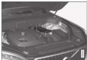
Ắc quy hỗ trợ được đặt trong hộp cạnh thanh giằng.
